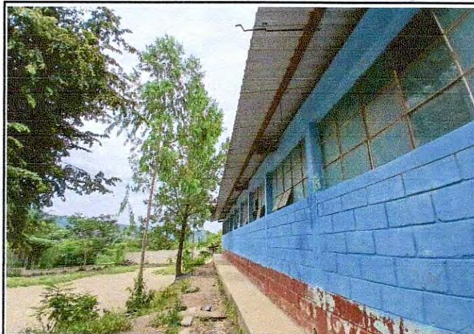
Foto1: Mejoramiento de canales y baja de agua pluvial
